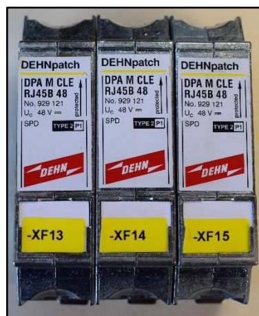
Abb. 15 Ethernet-Schnittstellen XF13, XF14, XF15
